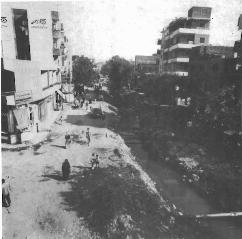
Photo 18 : Des égouts à ciel ouvert (cliché G. El Kadi)
