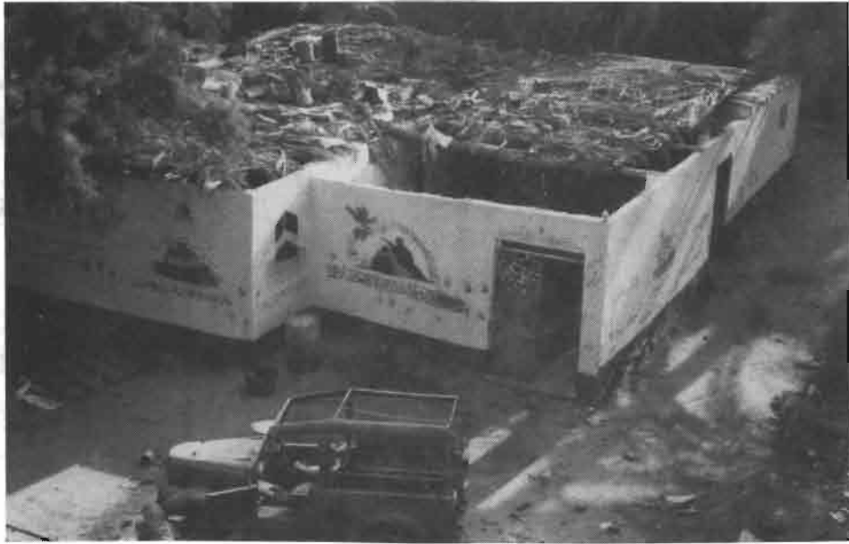
Photo 38 : Maisons à rez-de-chaussée (cliché G. EL Kadi)
