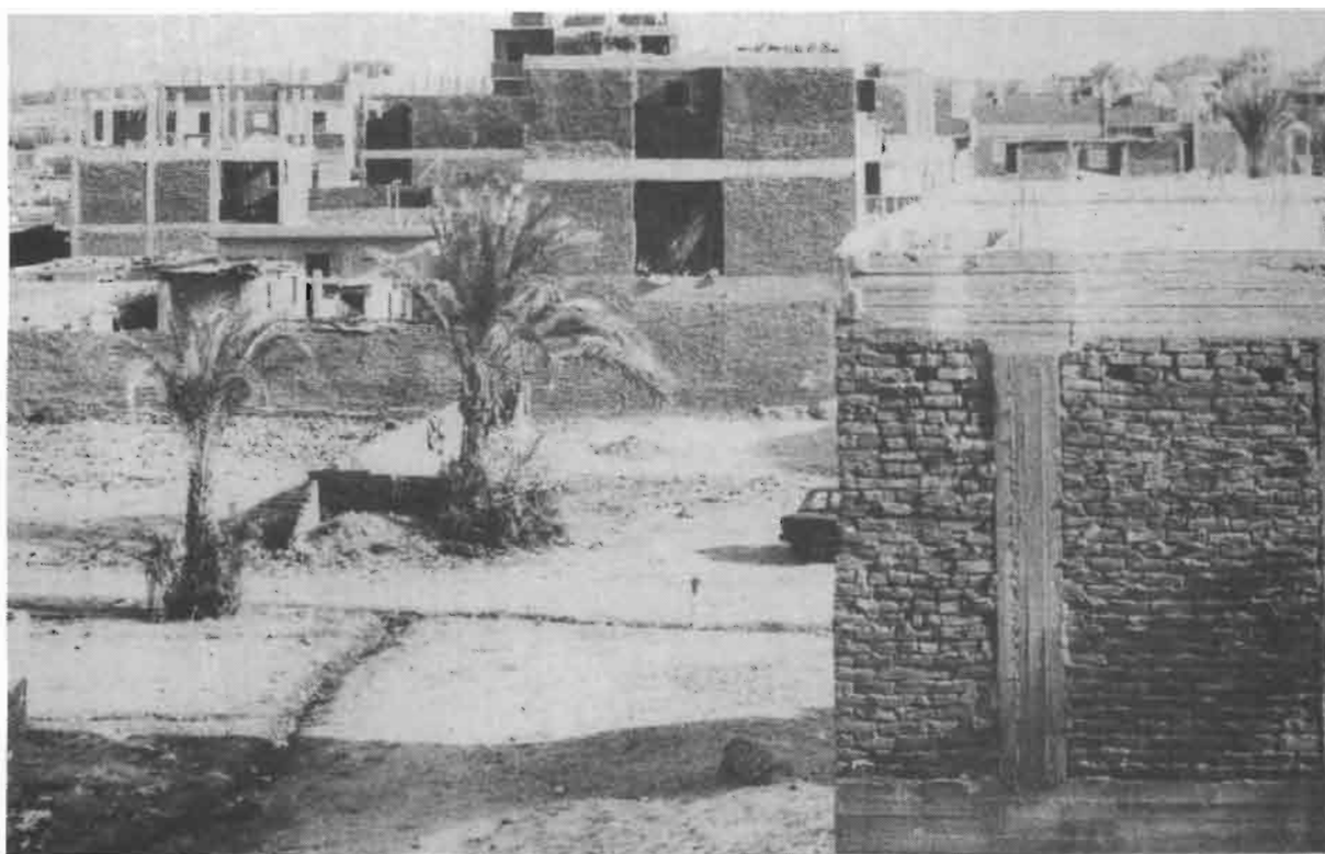
Photo 19 : L'absence d'enduit extérieur (cliché G. El Kadi)
