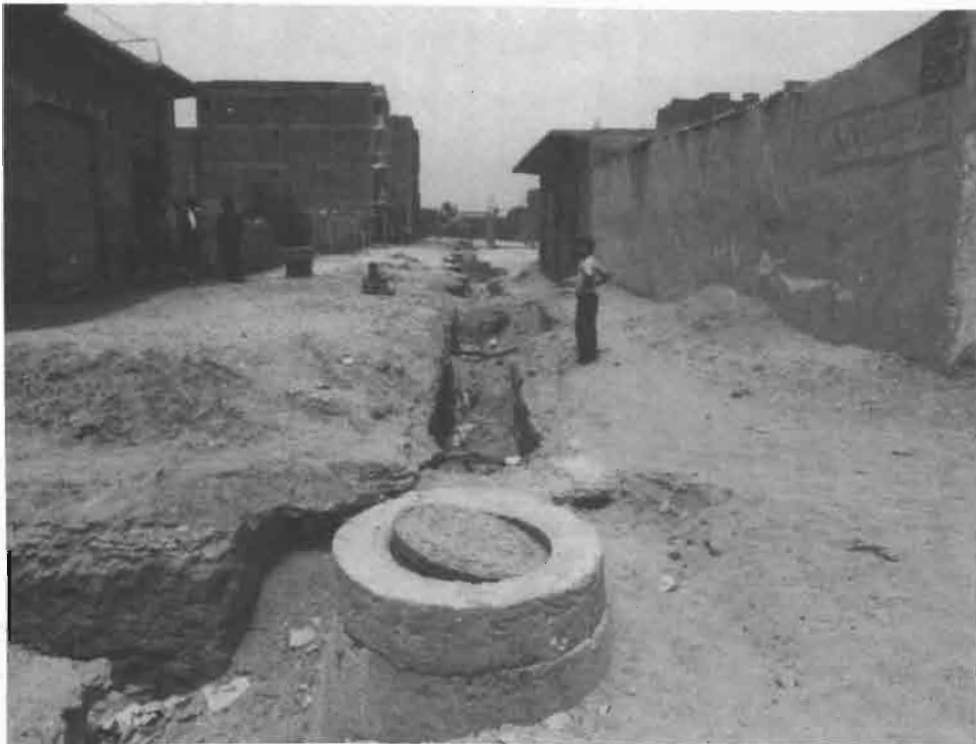
Photo 45 : Installation des égouts (cliché A. Bonnamy)
