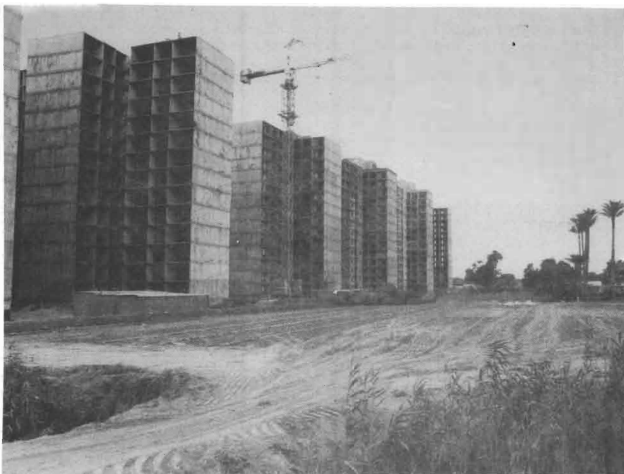
Photo 33 : Immeubles produits par les grandes entreprises B.T.P. (cliché G. El Kadi)
