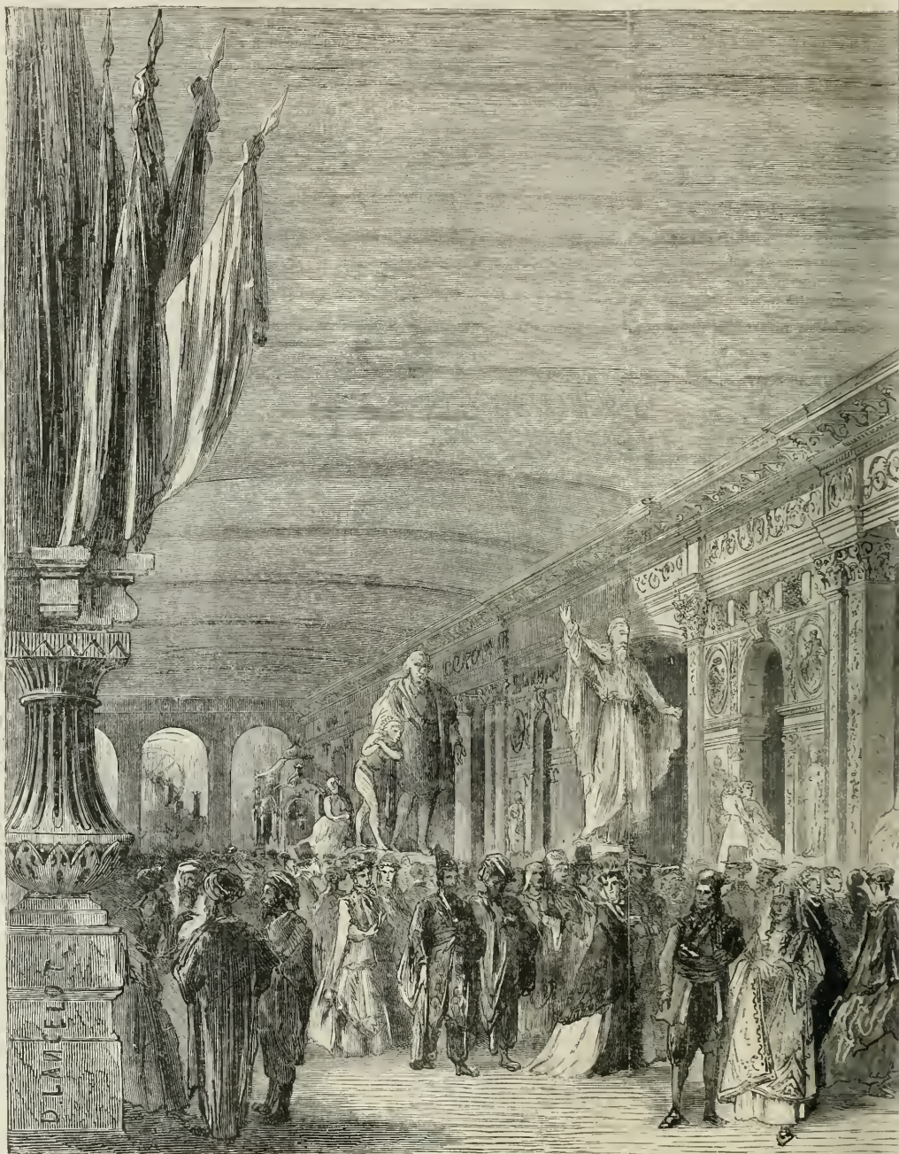
INSTALLATION DE LA GALE
