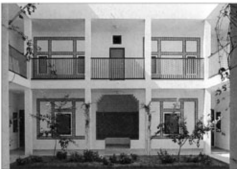
استمرارية الماضي: فندق تقليدي (أعلى الصورة) ومحاطه في قالب جديد في مشروع «دار الأندلس» سوسة، تونس، الفائز عام ١٩٨٣ (أسفل الصورة).
