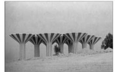
أبراج المياه في مدينة الكويت، بالكويت، أنجزت في عام ١٩٧٦ فائز في عام ١٩٨٠.
