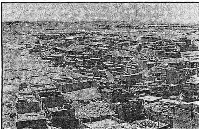
صورة (٥٩) : بعض مباني منشأة ناصر العشوائية بجوانب وقيعان بعض الأودية الجافة - مما يمثل خطراً عليها إذا ما انهارت عليها كتلاً صخرية من جوانب تلك الأودية.
