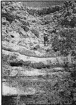
صورة (١٥) : أحد المنشآت الواقعة جنوبى كثبان الخانكة - على طريق القاهرة الإسماعيلية، وقد تمت تكمية تلك الكثبان بالحجر الجبرى والمواد الأسمنتية لحمايتها وغيرها من المنشآت من زحفها عليها.
