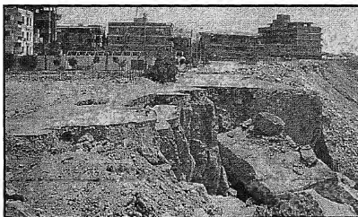
صورة (٥٤) : انهيار أجزاء كبيرة من الحافة الجنوبية الغربية للهبضية العليا بجبل المقطم لدرجة أدت إلى تلاشى أجزاء كبيرة من شارع الأهرام المعروف بطريق الكورنيش بجوارها مباشرة.
