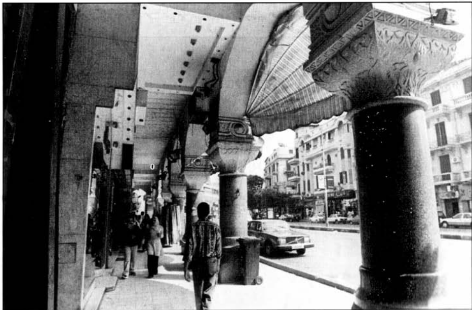
بواكى شارع إبراهيم اللقانى فى مصر الجديدة توفر المأوى ومساحة من الظل . . وتحمى المشترين من الأمطار شتاء .
