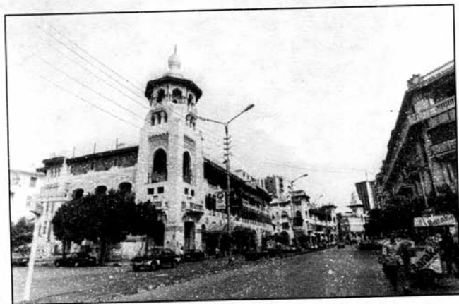
عمارات منطقة روكسى فى حى مصر الجديدة ارتبط عمرها بعمر الضاحية ، ومازالت صامدة رغم أن عمرها يقترب من المائة عام .
