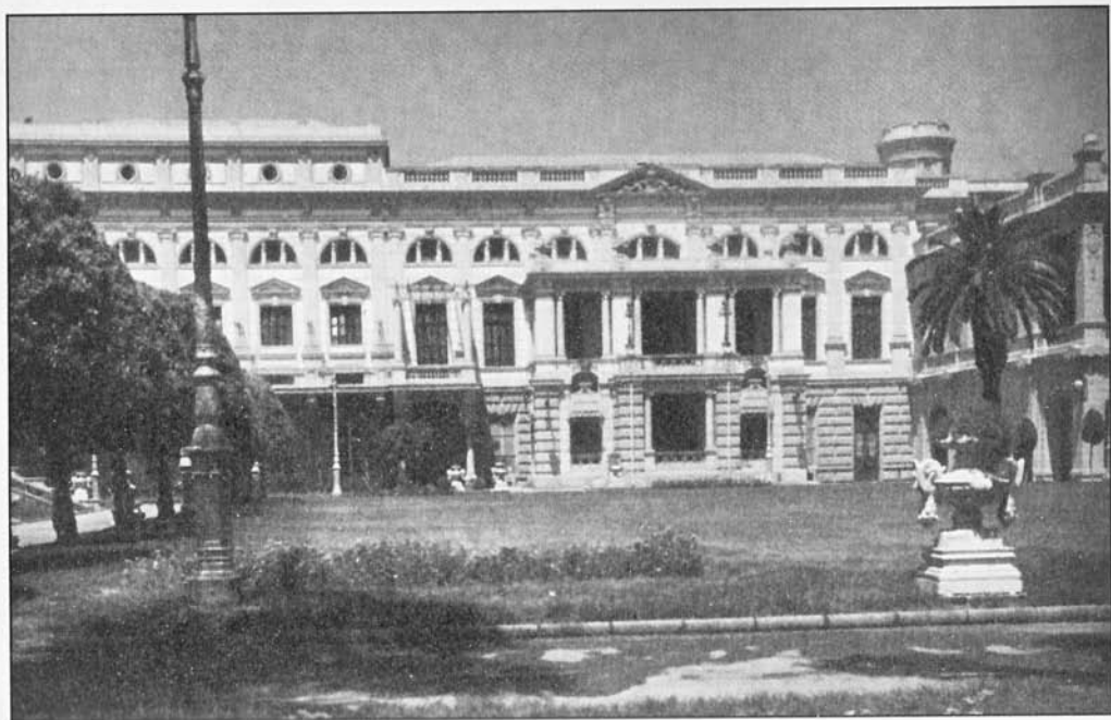
صورة مقر تاليدية للقصر عابدين . هي الواجهة الخلفية للقصر .
