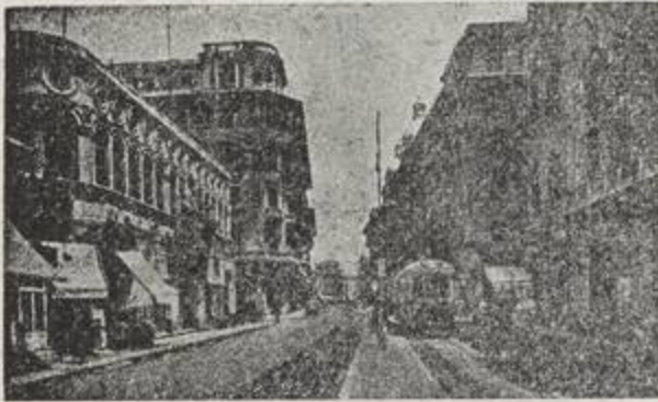
القاهرة — شارع عماد الدين وترى فى هذه الصورة الأثرية مبنى تياترو الكورسال قبل هدمه وقبل بناء عمارة عدس فى مكانه . وترى كذلك عمارات الحدوى وقطار القروى فى الشارع .
