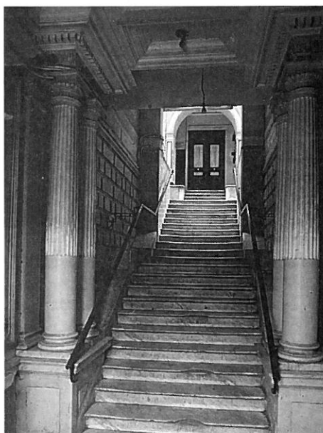
11. Algiers. Mixed-use block in rue d'Isly
